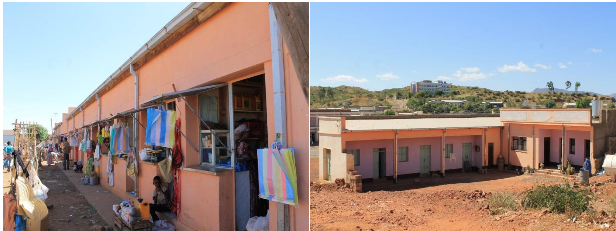
እዚ ጸጋማይ ህንጻ ኣብ ማእከል ከተማ ንግዳዊ ትካላት፡ እዚ ብዩማን ዘሎ ድማ ናይ ውልቀ መንበሪ ኣባይቲ፡
